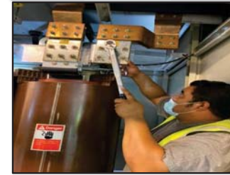
ขณะทำการ Check Torque
