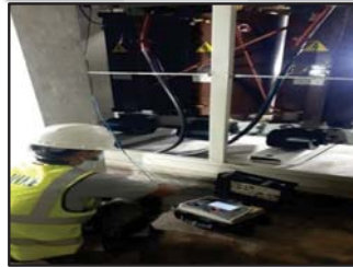
ขณะทำการทดสอบ Insulation Resistance
