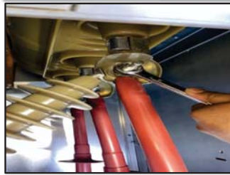
ขณะทำการขันแปนจุดต่อทางไฟฟ้า
