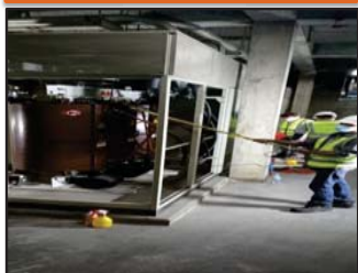
ขณะทำการ Check Voltage
