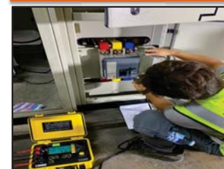
ขณะทำการทดสอบ Contact Resistance
