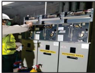
ขณะทำการ Check Voltage
