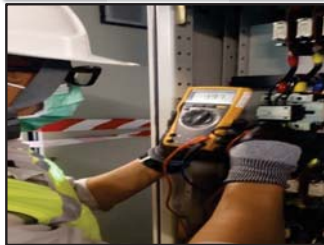
ขณะทำการวัดค่า Capacitance
