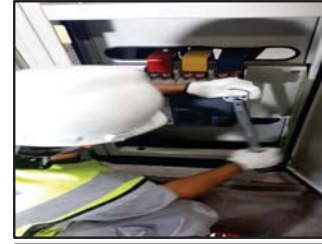
ขณะทำการ Check Torque
