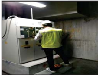
ขณะทำการ Check Voltage
