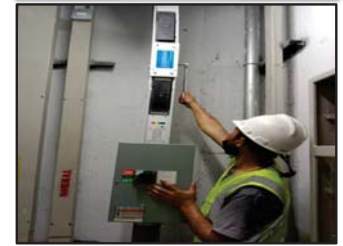
ขณะทำการ Check Torque
