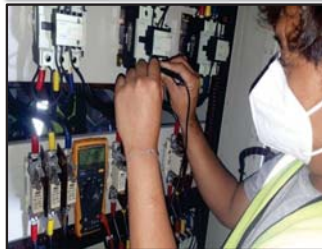
ขณะทำการวัดค่า Capacitance
