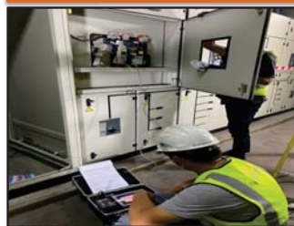
ขณะทำการทดสอบ Function Trip Unit
