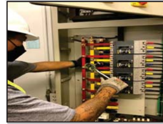
ขณะทำการขันแน่นจุดต่อทางไฟฟ้า
