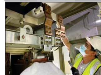
ขณะทำการ Check Torque
