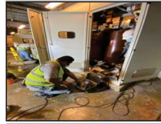
ขณะทำการทดสอบ Windin & Turn Ratio
