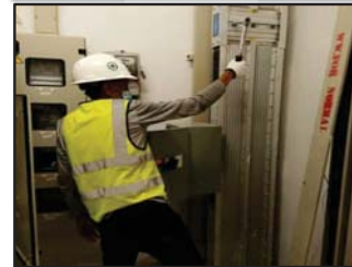
ขณะทำการ Check Torque
