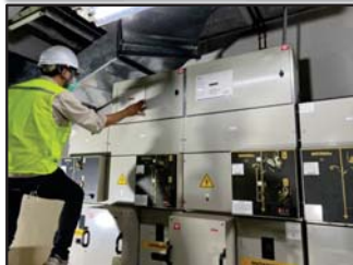
ขณะทำการ Check Voltage
