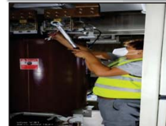
ขณะทำการ Check Torque
