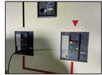
ขณะทำการทดสอบ Function Trip Unit
