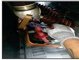
ขณะทำการขันแน่นจุดต่อทางไฟฟ้า
