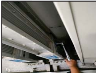
ขณะทำการ Check Torque
