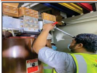
ขณะทำการ Check Torque
